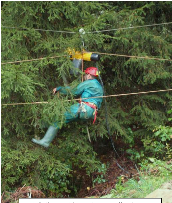
Installation cable porteur au gouffre 3
