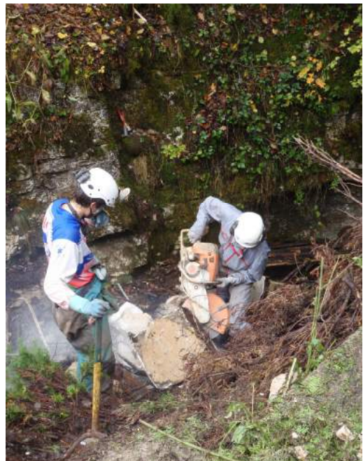
Découpage à la disceuse thermique
